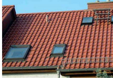
Bilder 2-18, 2-19: Ziegeldachdeckung vor und nach der Reinigung durch Besprühen mit einem Algen- und Moosentferner [Fotos: dachpflege.de GmbH, Schmallenberg]
