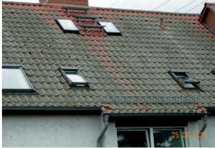
Bilder 2-18, 2-19: Ziegeldachdeckung vor und nach der Reinigung durch Besprühen mit einem Algen- und Moosentferner [Fotos: dachpflege.de GmbH, Schmallenberg]
